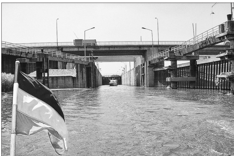
Слика 2. Бродска преводница у оквиру бране код Новог Бечеја (rkm 63)
