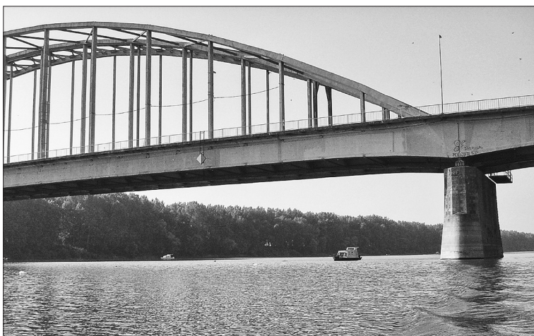
Слика 3. Мост код Титела (rkm 9)
