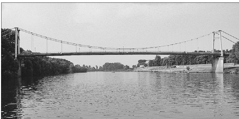
Slika 4. Most kod Novog Kneževca na km 144 - nizvodno (foto: D. Pavić)
