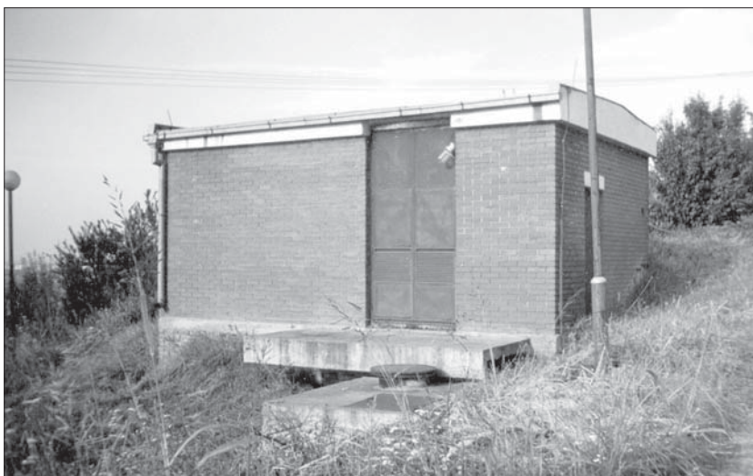
Сл. 4. Водоводни резервоар на Салаксији Fig. 4. Water Container in Salaksija
